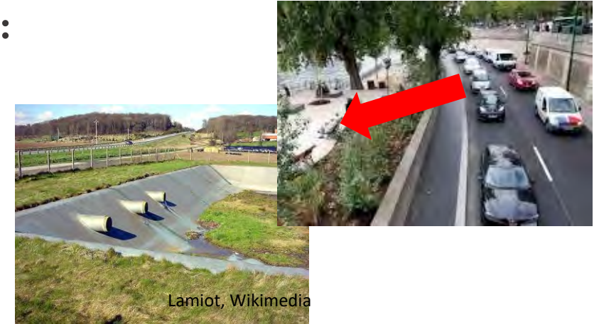
Bassin de rétention des eaux de ruissellement d'une autoroute
