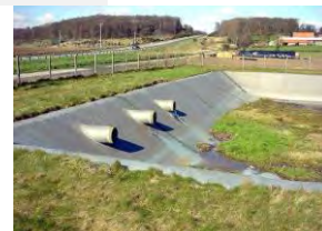
Bassin de rétention des eaux de ruissellement d'une autoroute
